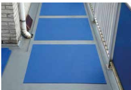
Montage op beton
