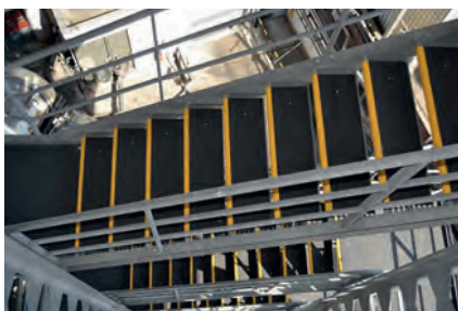
Pose sur escaliers
