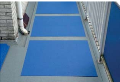
Montage op beton
